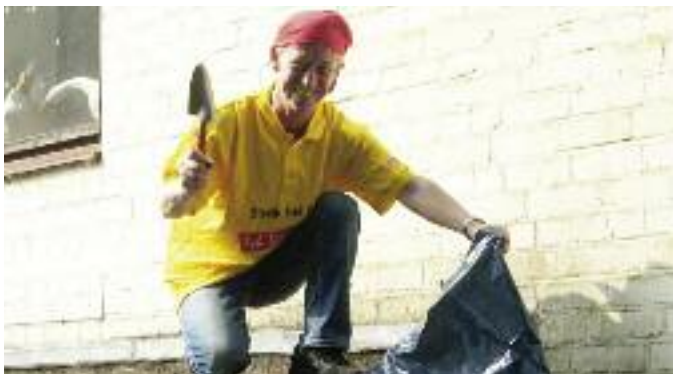
Wuppertal: Streikende haben die Renovierung der Kita „Zwergenburg“ fortgesetzt
